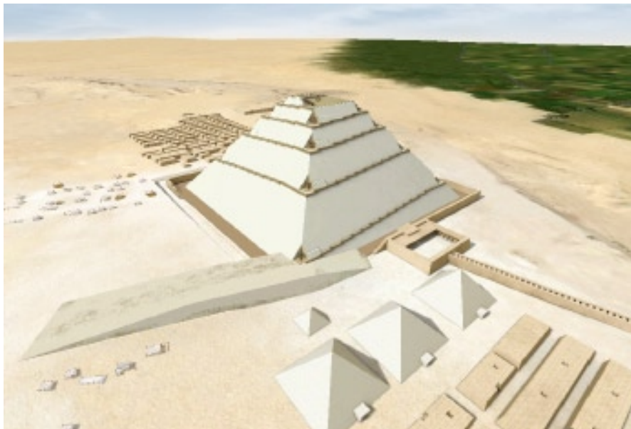
19ème année du règne. Le chantier, vu du Nord-Ouest, atteint le niveau +113m. La Chambre du Roi est terminée depuis longtemps, la pyramide est construite avec les matériaux récupérés lors du démantèlement de la rampe extérieure. Les blocs sont dorénavant transportés par la rampe intérieure jusqu'à leur place définitive.
