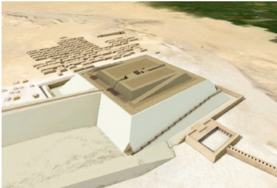
15 ème année du règne. La pyramide ressemble à une pyramide à 2 degrés : le premier, définitif, de la base au niveau +43m, le second, en retrait d'une vingtaine de mètres des faces, du niveau +43m au niveau +54m. Ce degré est construit autour de la Chambre du Roi, au fur et à mesure de sa construction. A ce niveau +54m, le 3 ème plafond est en cours de mise en place.
