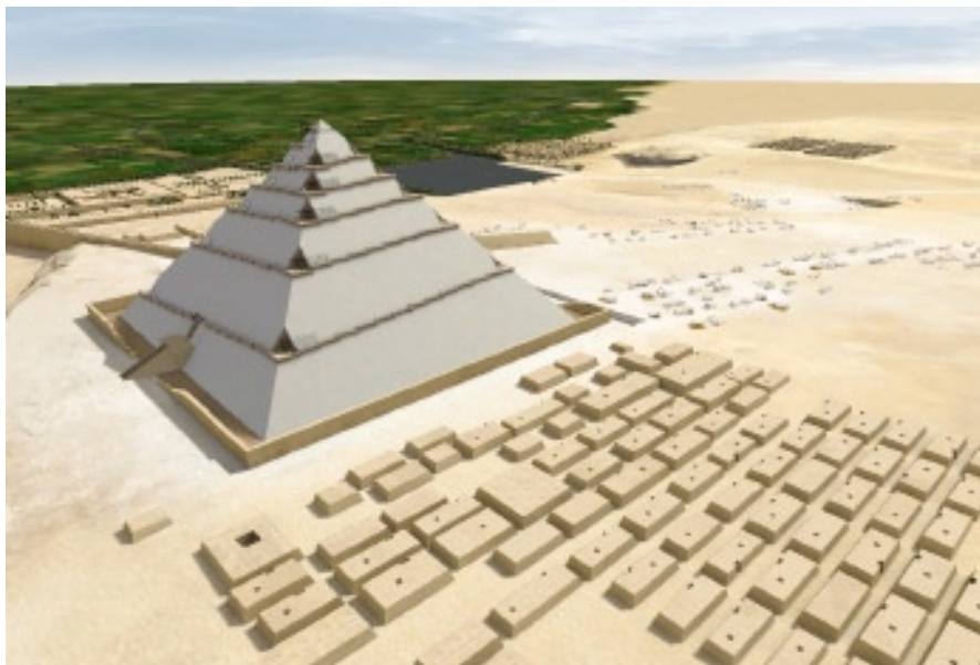
20ème année du règne. Le sommet est atteint, les travaux de parachèvement vont commencer depuis le sommet et en redescendant : rebouchage des encoches, démontage de la coursive extérieure, surfacage des derniers blocs de façade encore bruts.
