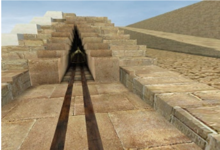
15 ème année du règne. La rampe intérieure débouche au niveau +43m, elle n'est pas encore utilisée pour construire la pyramide mais est déjà intégrée dans la pyramide depuis le niveau +7m. A droite, le second degré est en cours de construction pour permettre la mise en place des plafonds de la Chambre du Roi.
